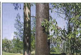
右太い方は樹に似せた電柱。左電柱の中。
